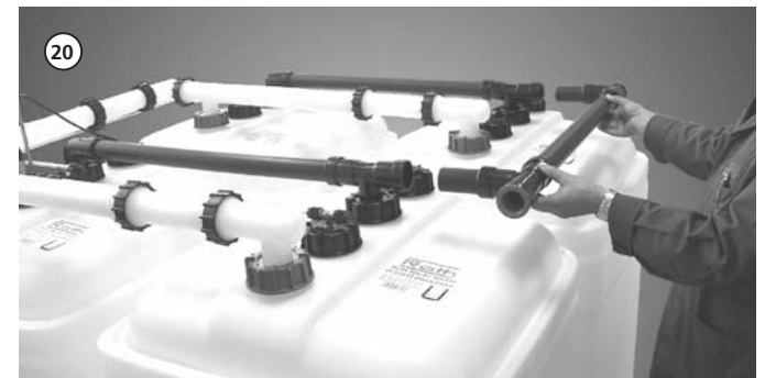
Zamontować wcześniej przygotowany kolektor odpowietrzenia;
