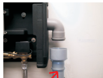
Przyłącze do odprowadzenia wody
