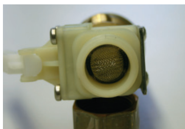
Wkładka z sitkiem zamontowana na dopływie zaworu
